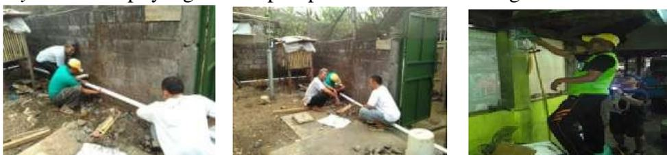
**Gambar 5.6.** Pemasangan saluran *slurry*
