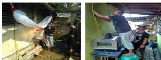
**Gambar 5.8** Instalasi Saluran Biogas ke kompor dan Petromaks
