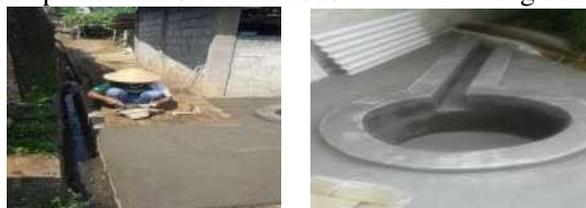
**Gambar 5.5** Pekerjaan Lantai/Paving dan Bak Penampung *Slurry*
